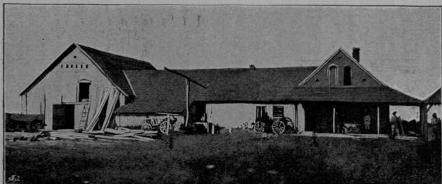
Die Kolonie Windhorst im Entstehen.
