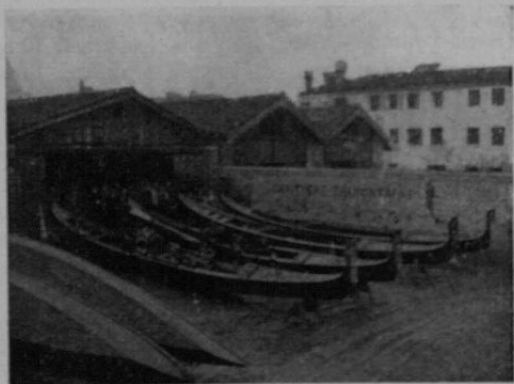
Il cantiere Tramontin
