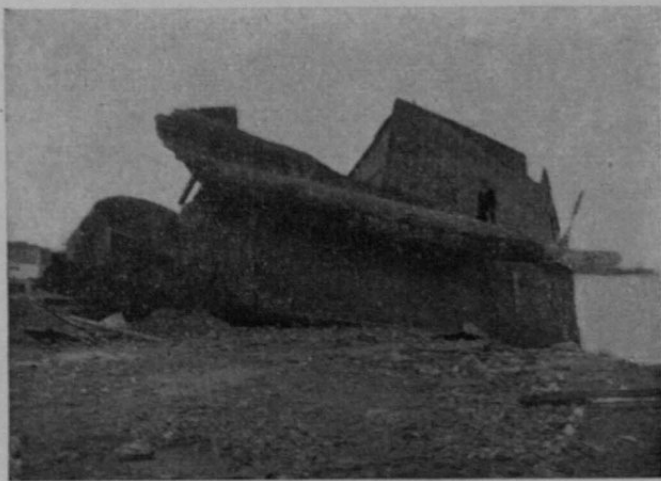
Ricupero di parte dell'Oceania, affondata nel porto di Pola. (I pontoni di sollevamento hanno la potenza di 3500 q.li)
