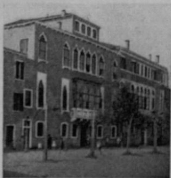
Palazzo Foscari (secolo XV) (Fondamenta S. Blazio)
