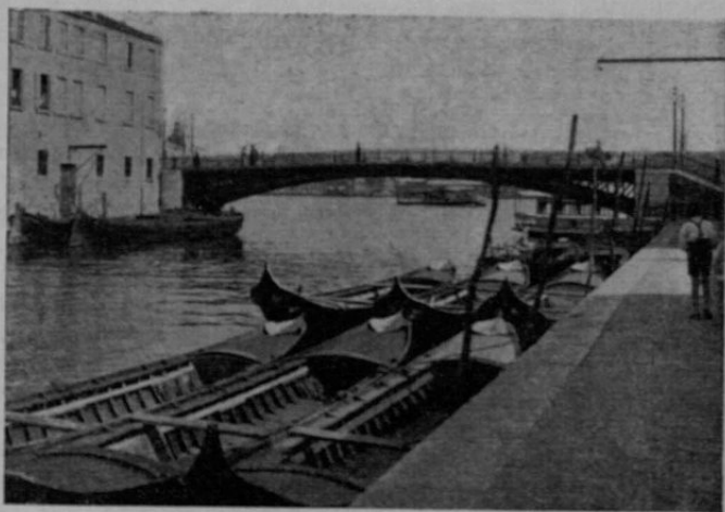
Il Ponte Lungo
