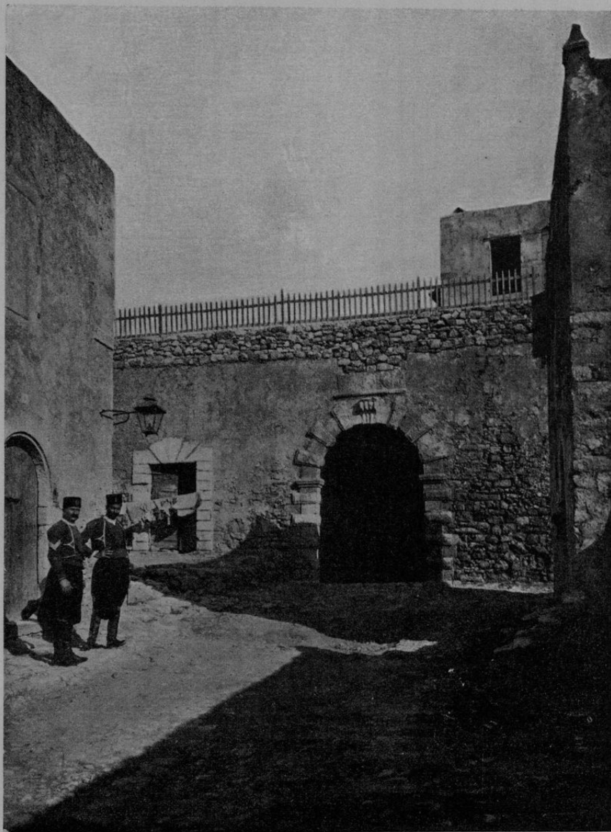
FIG. 303 — RETIMO: FACCIATA INTERNA DELLA PORTA DELLA FORTEZZA. (339).
