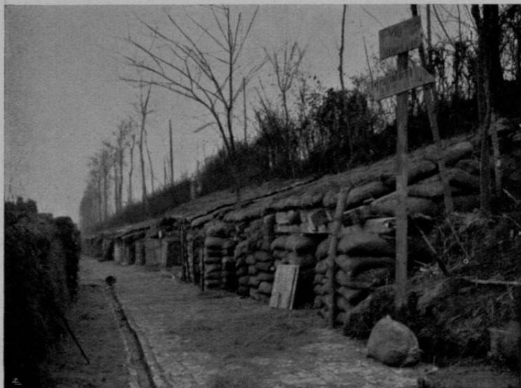
SISTEMAZIONE DIFENSIVA DEL 1° REGG. GRANATIERI LUNGO L'ARGINE REGIO DEL PIAVE, DI FRONTE A FOSSALTA
