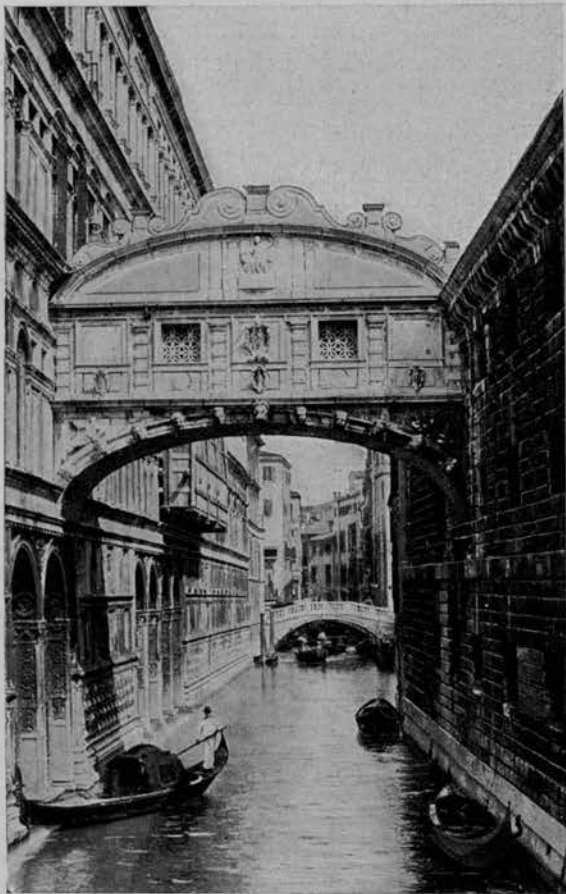
ARCH. ANTONIO CONTINO (?) (1600) — IL PONTE DEI SOSPIRI.
