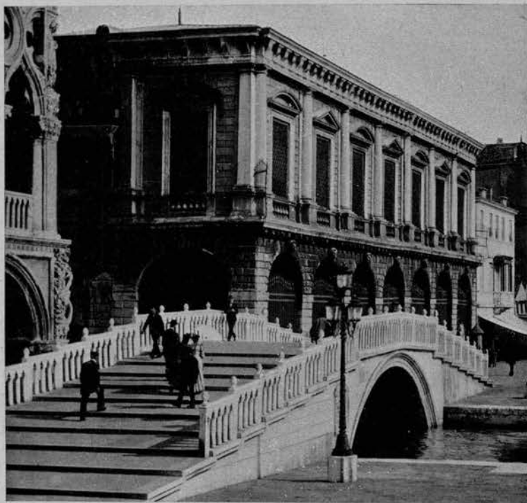
ARCH. ANTONIO DA PONTE (1589) — LE PRIGIONI AL PONTE « DELLA PAGLIA ».
