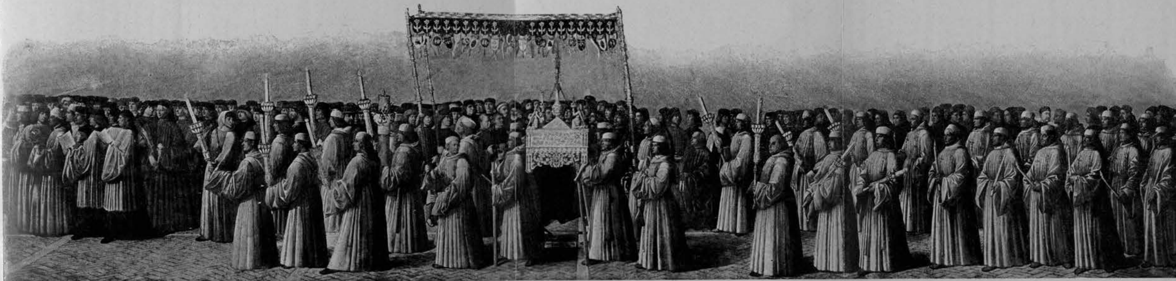
PROCESSIONE SULLA PIAZZA DI SAN MARCO — PARTICOLARE DEL QUADRO DI GENTILE BELLINI.
