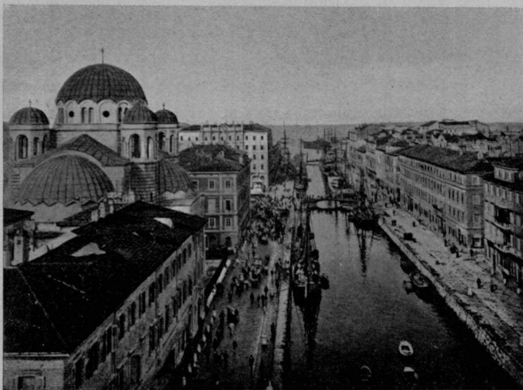
LO SBocco SUL CANALE.
