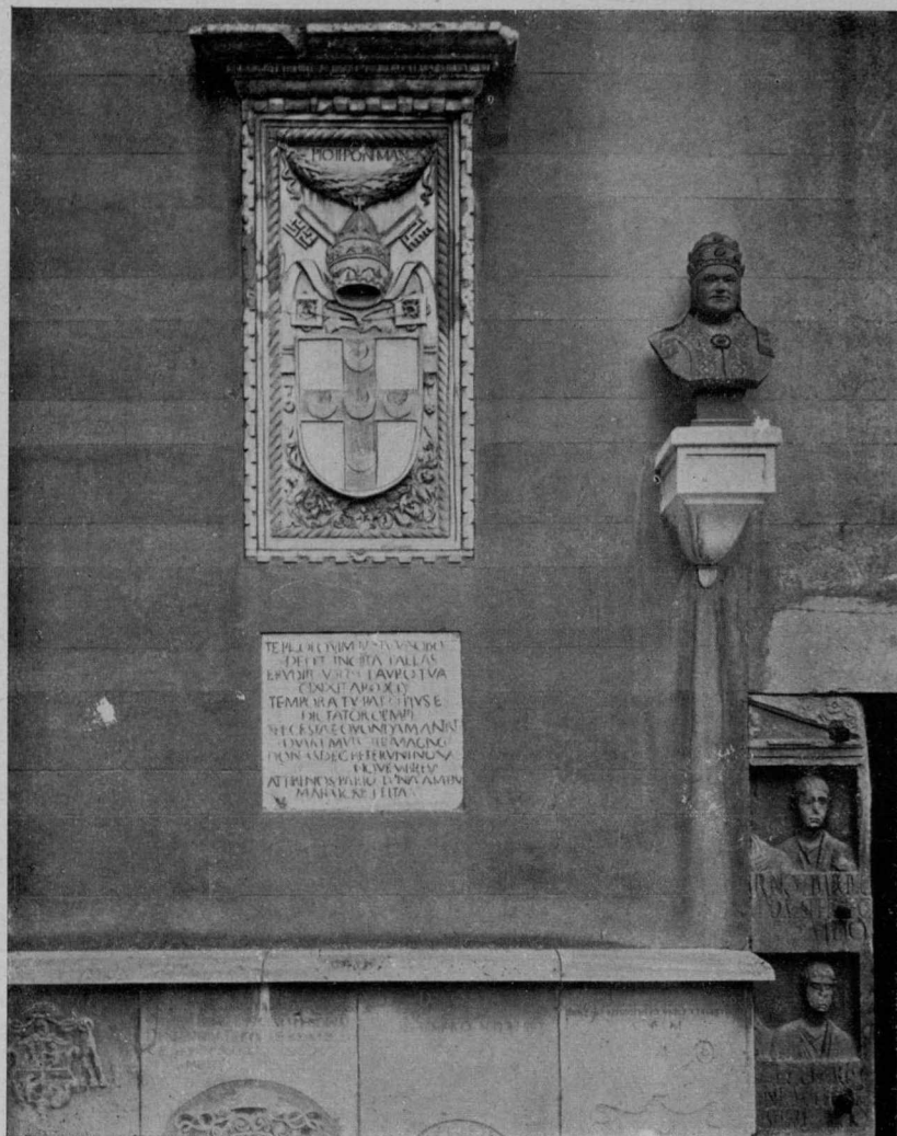
S. GIUSTO — PARTICOLARE DELLA FACCIATA.
