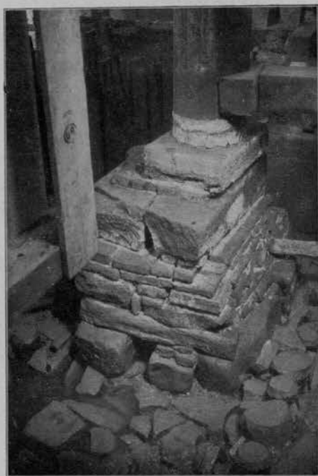
Fig. 80 - Fondazione delle colonne come furono trovate.
