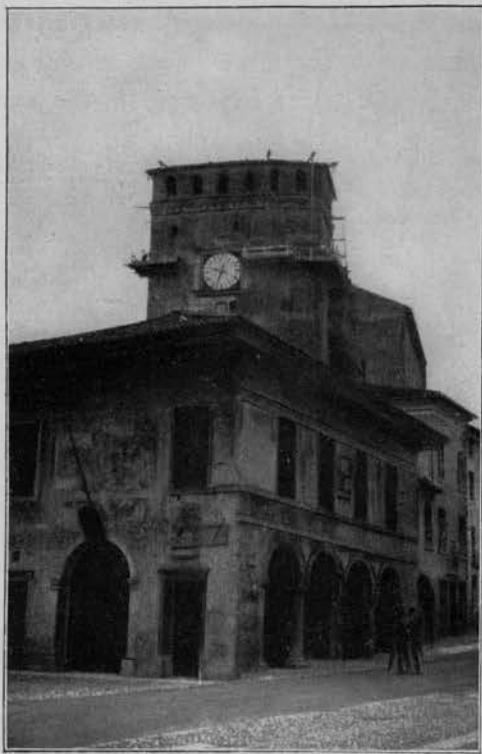
Fig. 123 - Asolo. Torre del castello durante i restauri.
