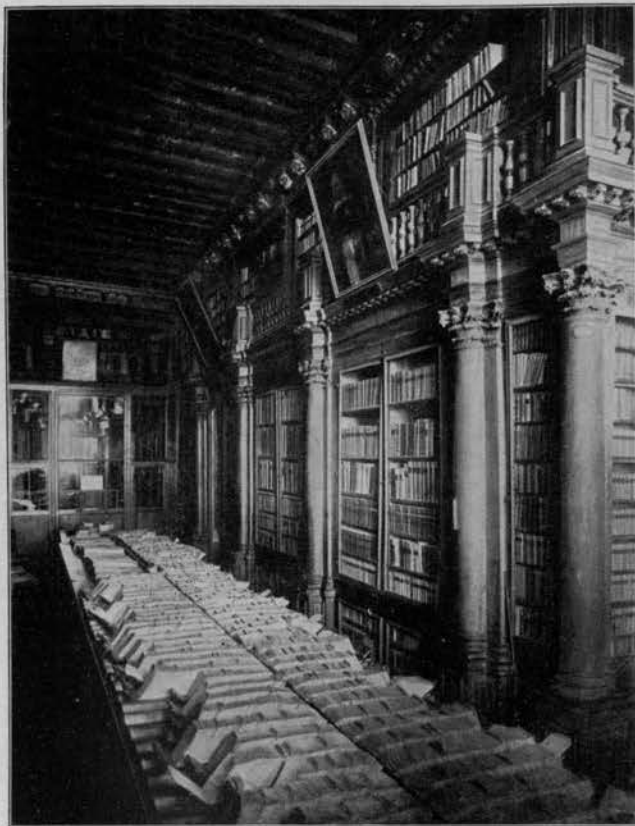
Fig. 2 - Sala dei Cataloghi prima del restauro.
