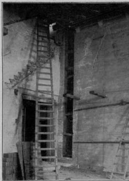
Fig. 3 - Muro della Sala Bessarione.
