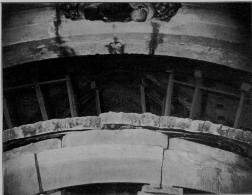
Fig. 40 - Cappella dell'Addolorata. L'antica vòlta trovata sopra la vòlta attuale.
