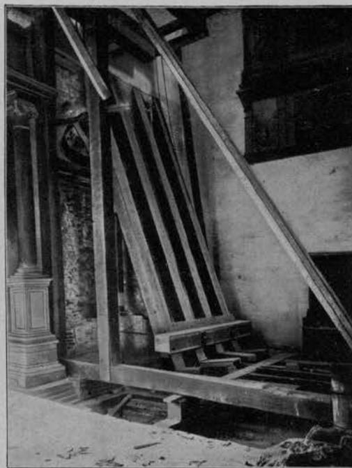
Fig. 31 - Armatura per il lievo dell'altare e ristauo del muro al lato destro della porta sotto la gran vetrata del Vivarini.
