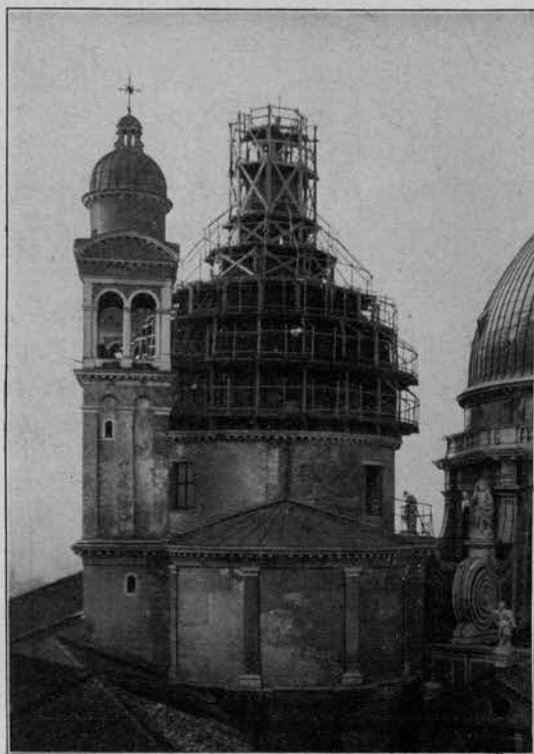
Fig. 77 - Chiesa della Salute. Armature per il restauro della cupola.
