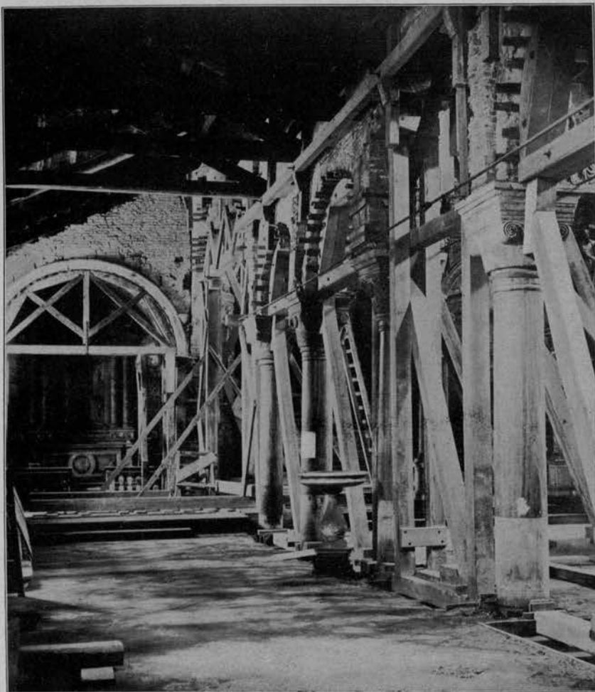
Fig. 78 - S. Nicolò dei Mendicoli. Lavori di presidio.
