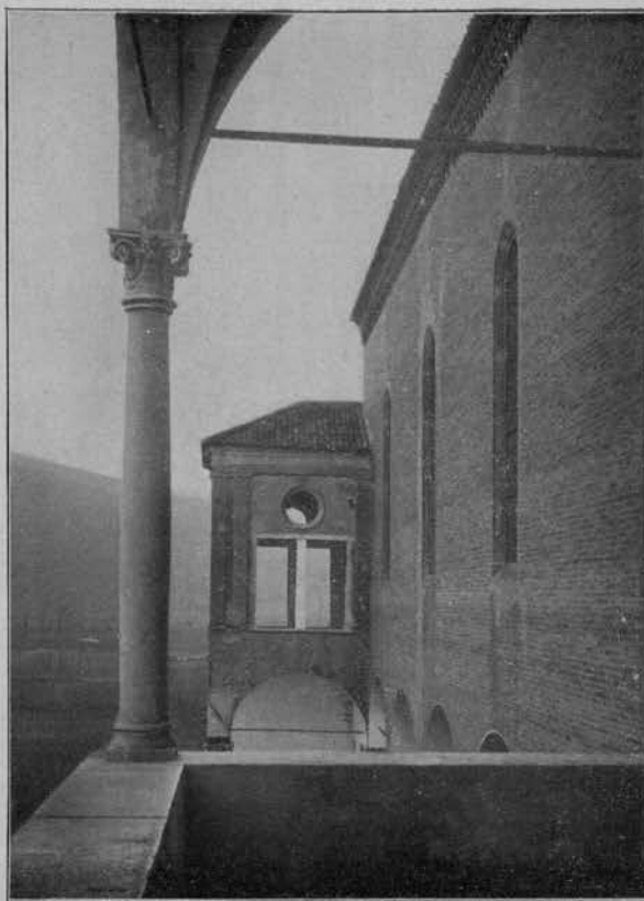
Fig. 111 - Praglia. Loggetta dopo il restauro.
