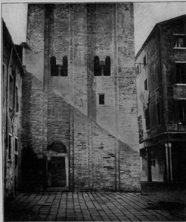
Fig. 87 - Parte inferiore del campanile dopo i restauri.
