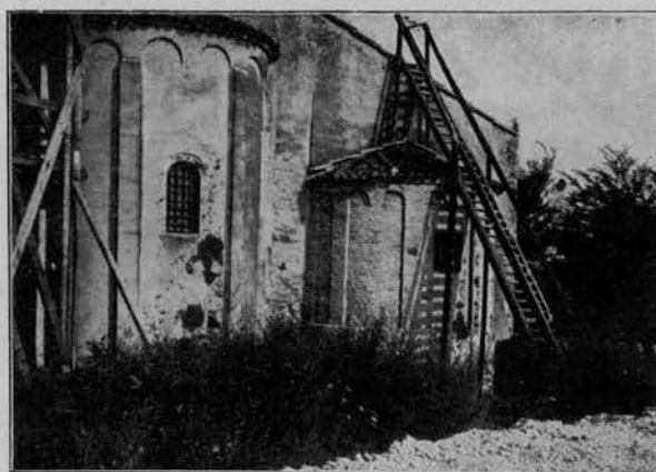
Fig. 97 - Duomo di Torcello. Absidula dopo il restauro.
