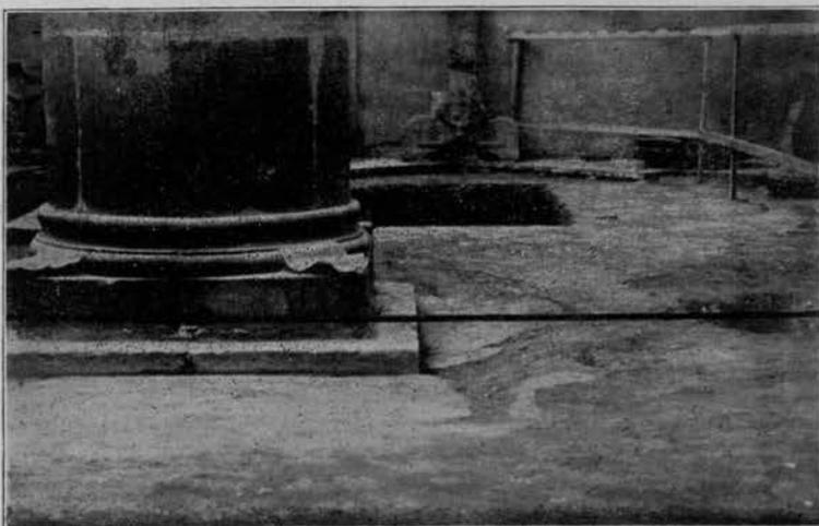
Fig. 177 - Cedimento di una delle colonne apparso dopo levato il pavimento a quadri.
