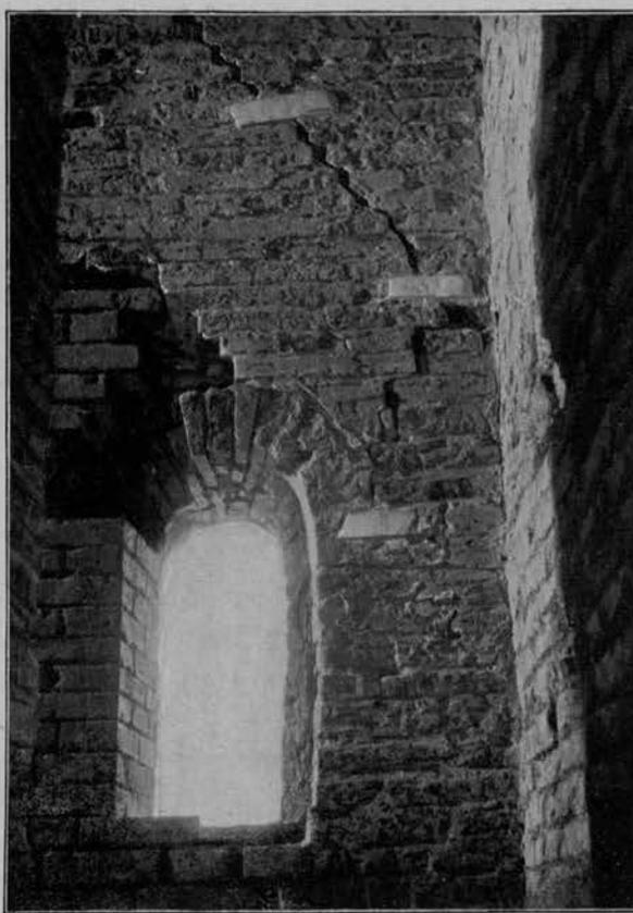
Fig. 94 - Torcello. Stato delle murature del campanile del Duomo.
