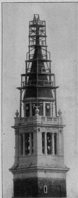
Fig. 88 - Armatura per il restauro dell'Angelo.
