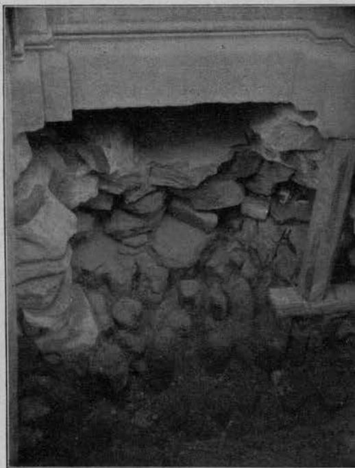
Fig. 39 - Stato in cui furono trovate le fondazioni della Cappella dell'Addolorata.
