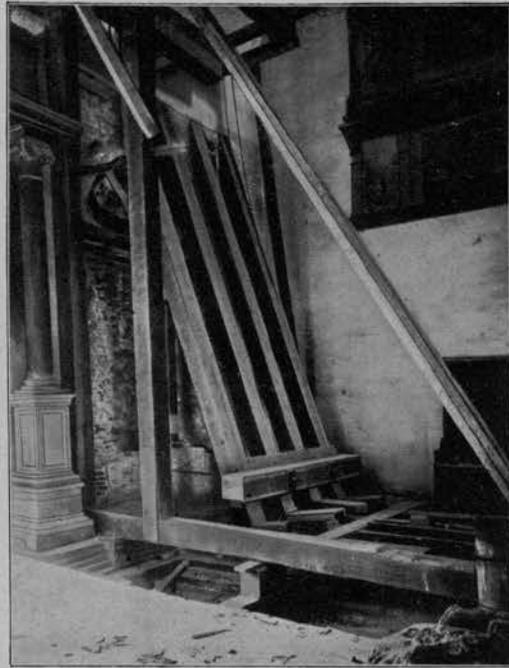
Fig. 31 - Armatura per il lievo dell'altare e ristauo del muro al lato destro della porta sotto la gran vetrata del Vivarini.
