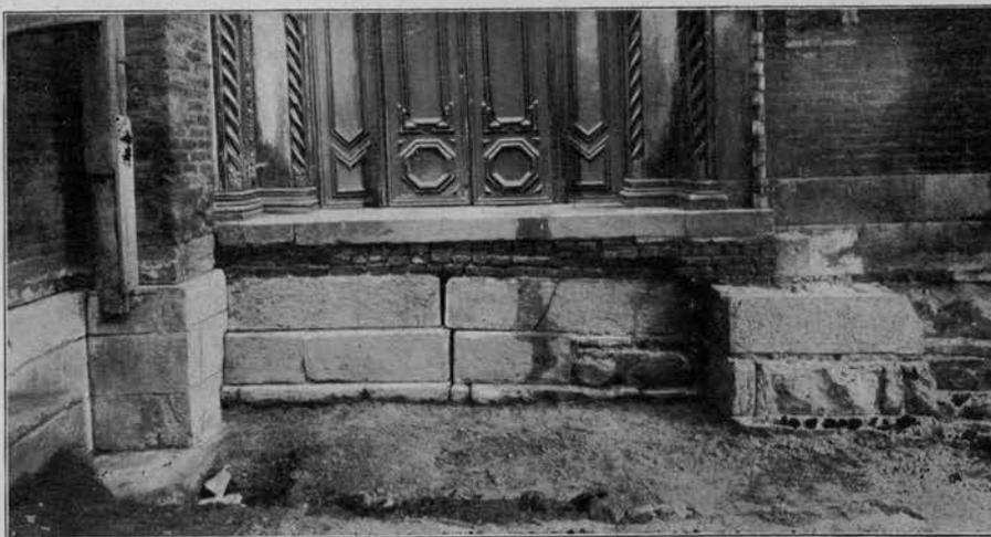
Fig. 58 - Stato delle murature sotto la porta detta dei morti prima del restauro.
