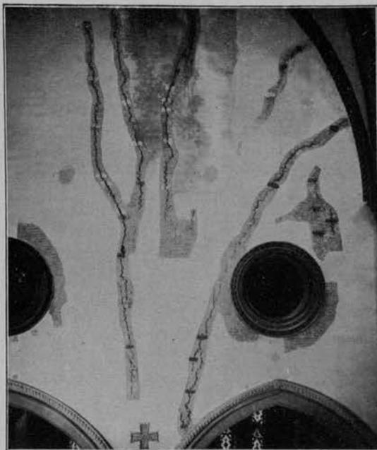
Fig. 44 - Fenditure nel muro est del braccio sinistro presso la Cappella del Rosario.
