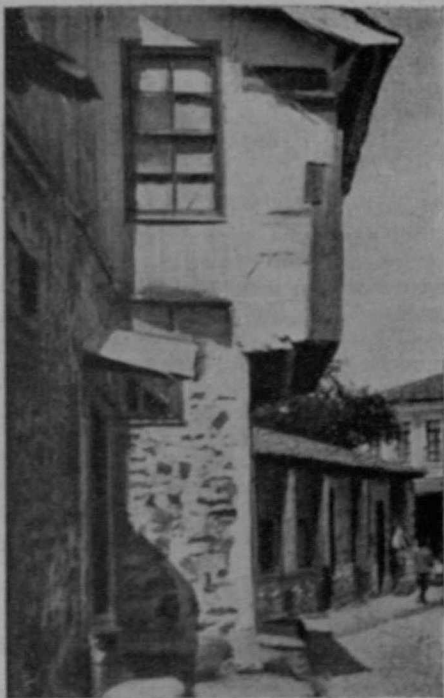
Casa di Coritza, con la caratteristica veranda avanzata.
