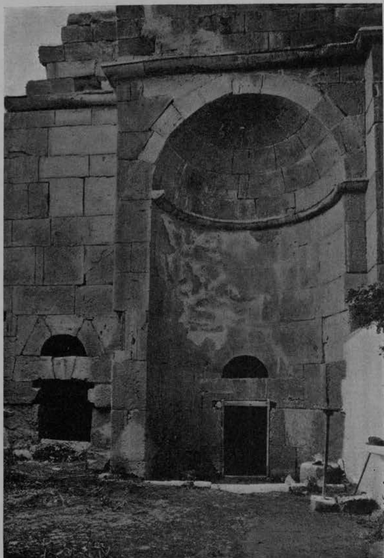
FIG. 13 — * MITRÒPOLIS — ABSIDIOLA DI PASSAGGIO ALLA ΠΡΟΘΕΣΙΣ NEL TEMPIO DI S. TITO. (832).
