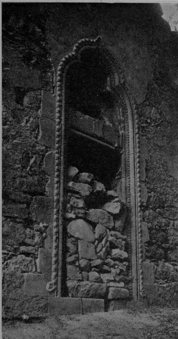
FIG. 335 — * SÀRKHOS (MALVESIN) — PORTA DELLA CHIESA DI S. MARIA, (656).
