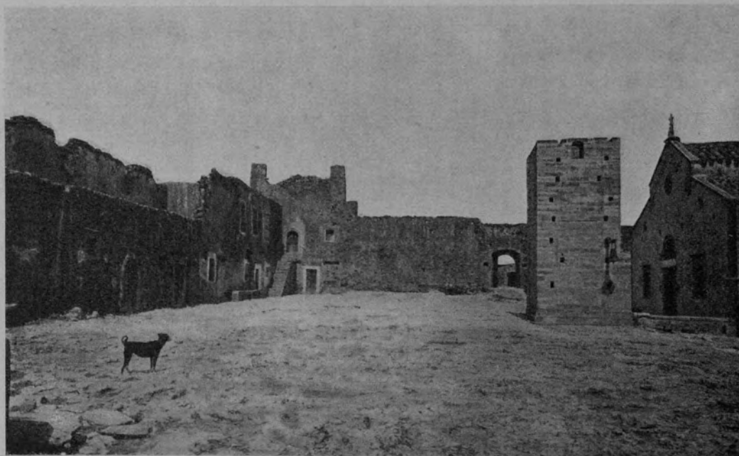
FIG. 95 — * APEŞANÈS — L'INTERNO DEL CONVENTO. (854).
