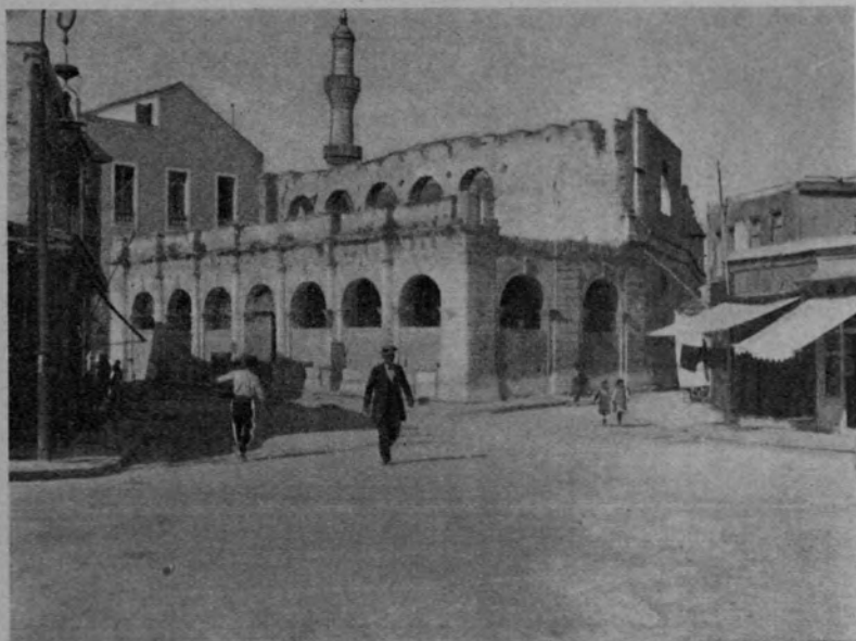
FIG. 15 — CANDIA — LA LOGGIA DOPO LA DEMOLIZIONE DEL PIANO SUPERIORE.
