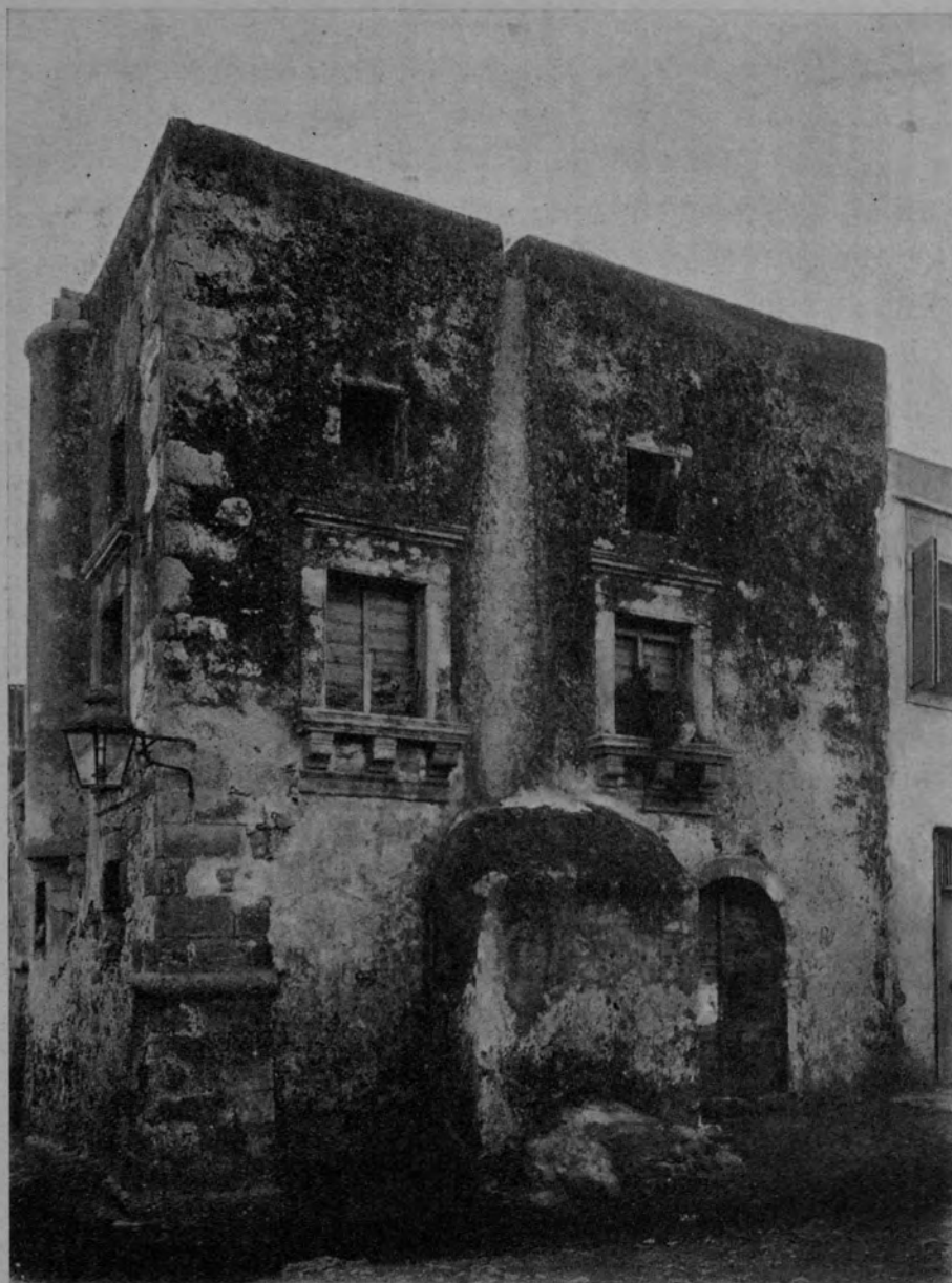
FIG. 136 — RETIMO — CASA IN FORTEZZA. (359).
