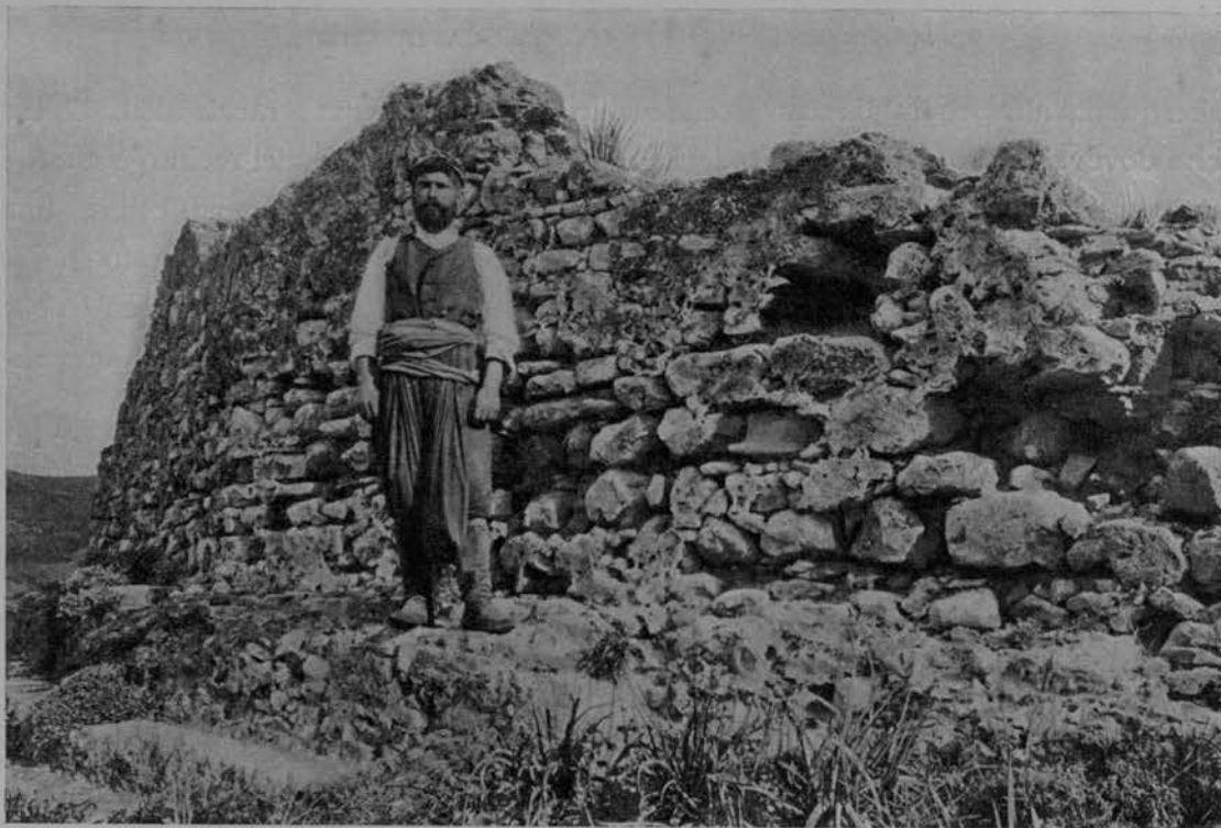
FIG. 116 — CASTEL NUOVO: IL MURO DELLA TORRE ALL'ESTERNO. (823).
