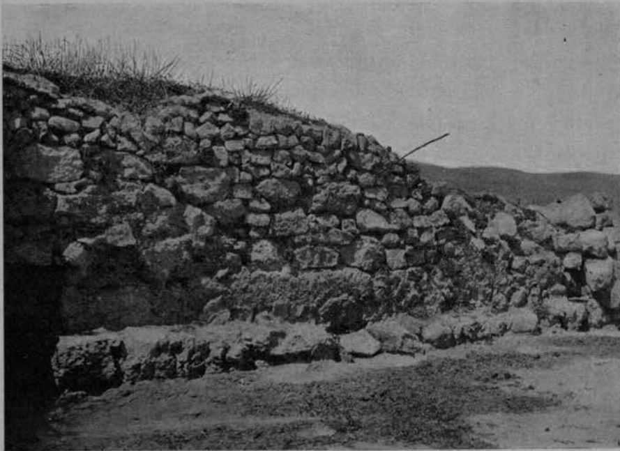
FIG. 119 — CASTEL MALVESIN: RUDERI DELLA TORRE. (669).
