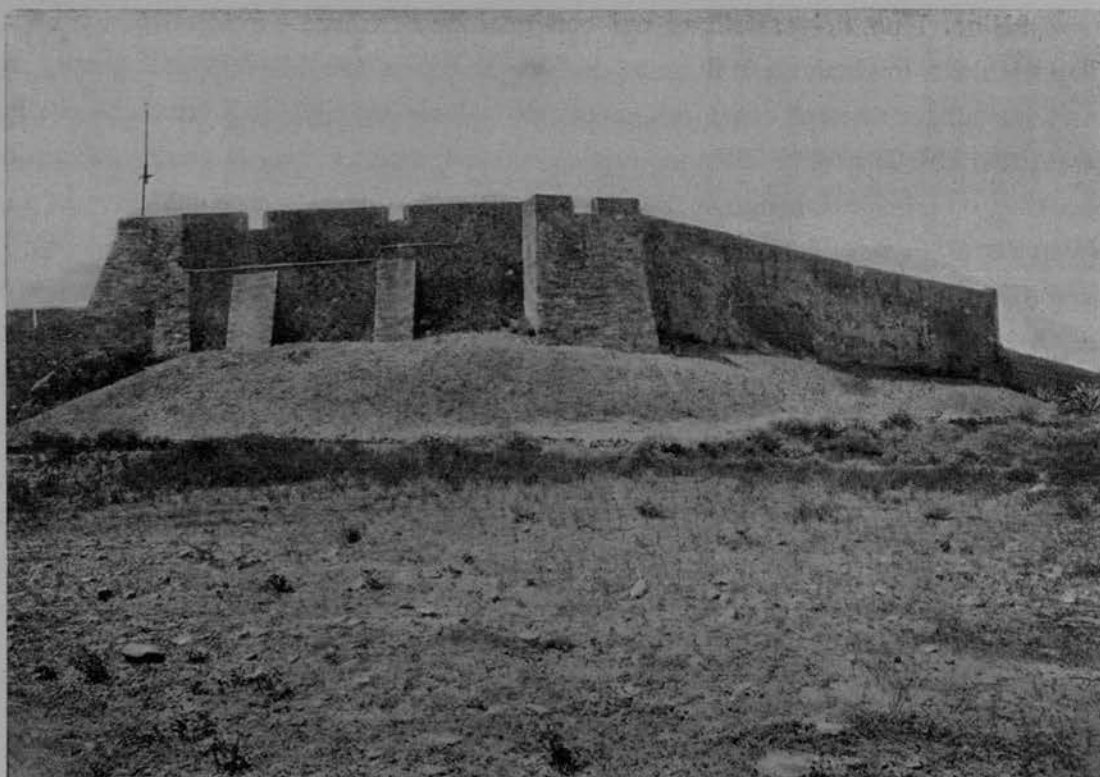
FIG. 122 — CASTEL CHISSAMO. ESTERNO DELLA ROCCA VERSO IL MARE. (400).
