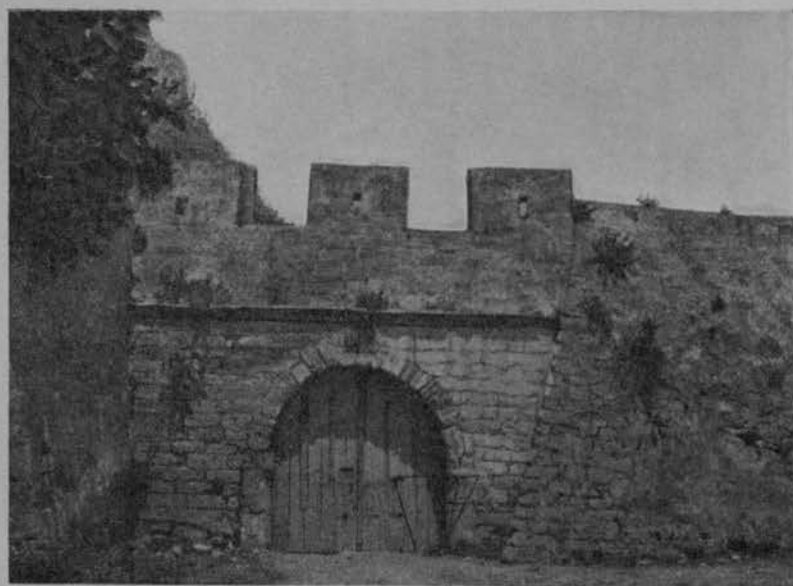
FIG. 62 — CANDIA — PORTA CHE MENA AL BALUARDO DELLA SABBIONARA, VISTA DALL'ESTERNO. (13).
