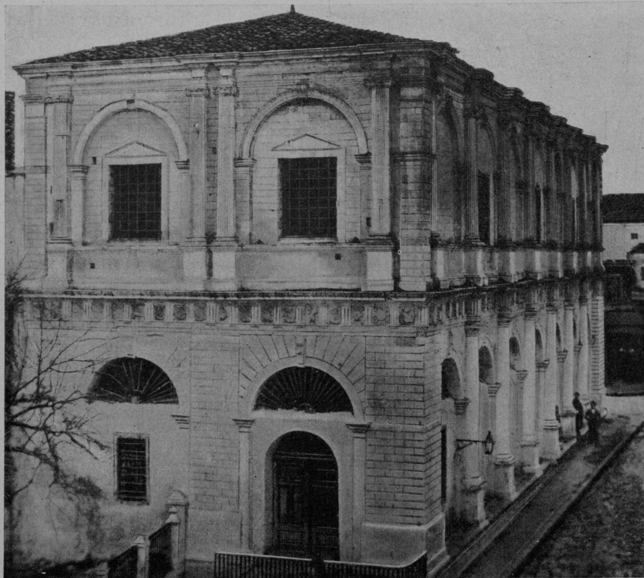
FIG. 12 — CANDIA — LA LOGGIA, VISTA DA NORD-OVEST, PRIMA DELLA DEMOLIZIONE.
