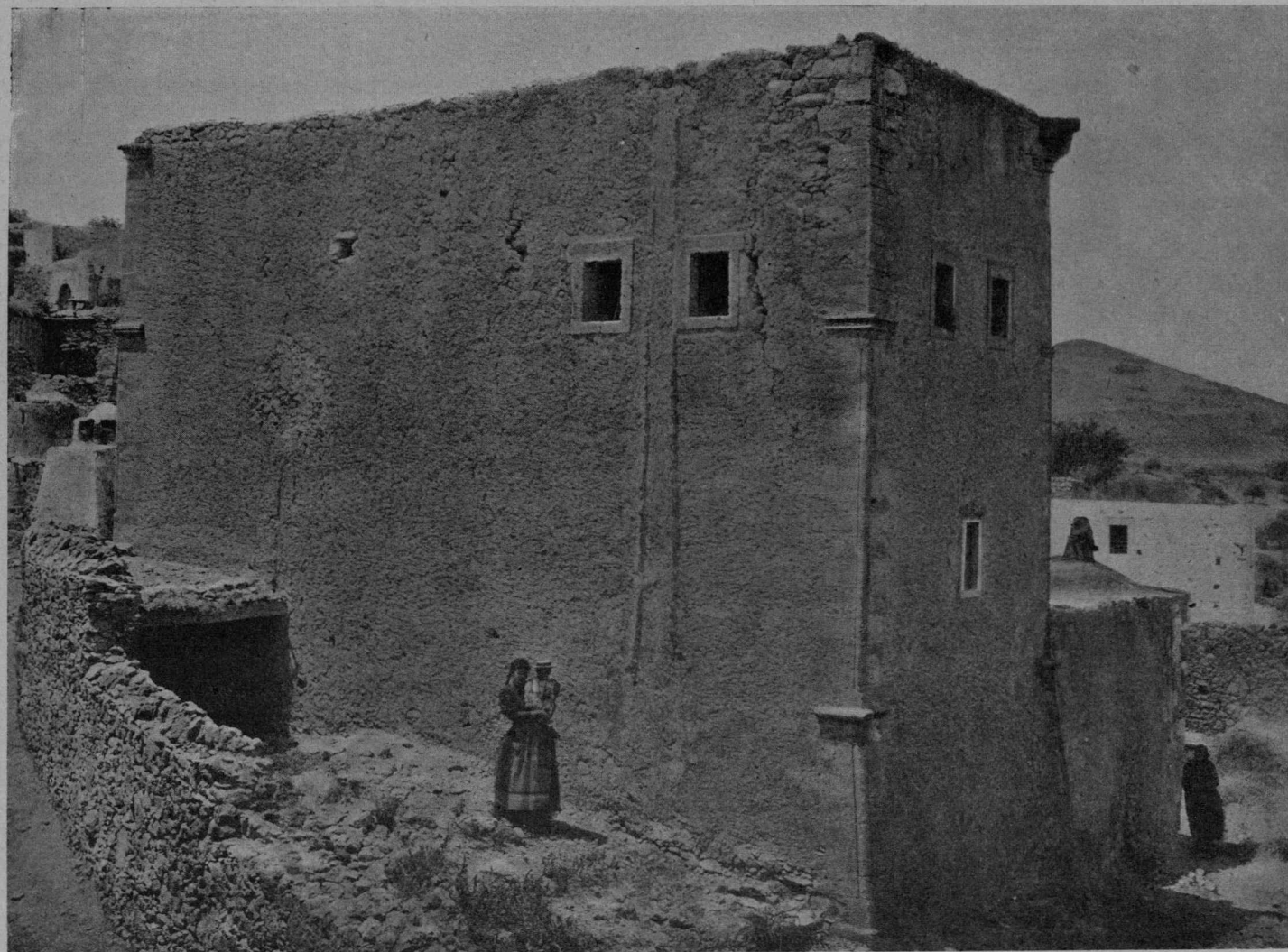
FIG. 202 — * KUSÈ — LA PRIMA TORRE DEI CURMULI, DA NORD-EST. (848).
