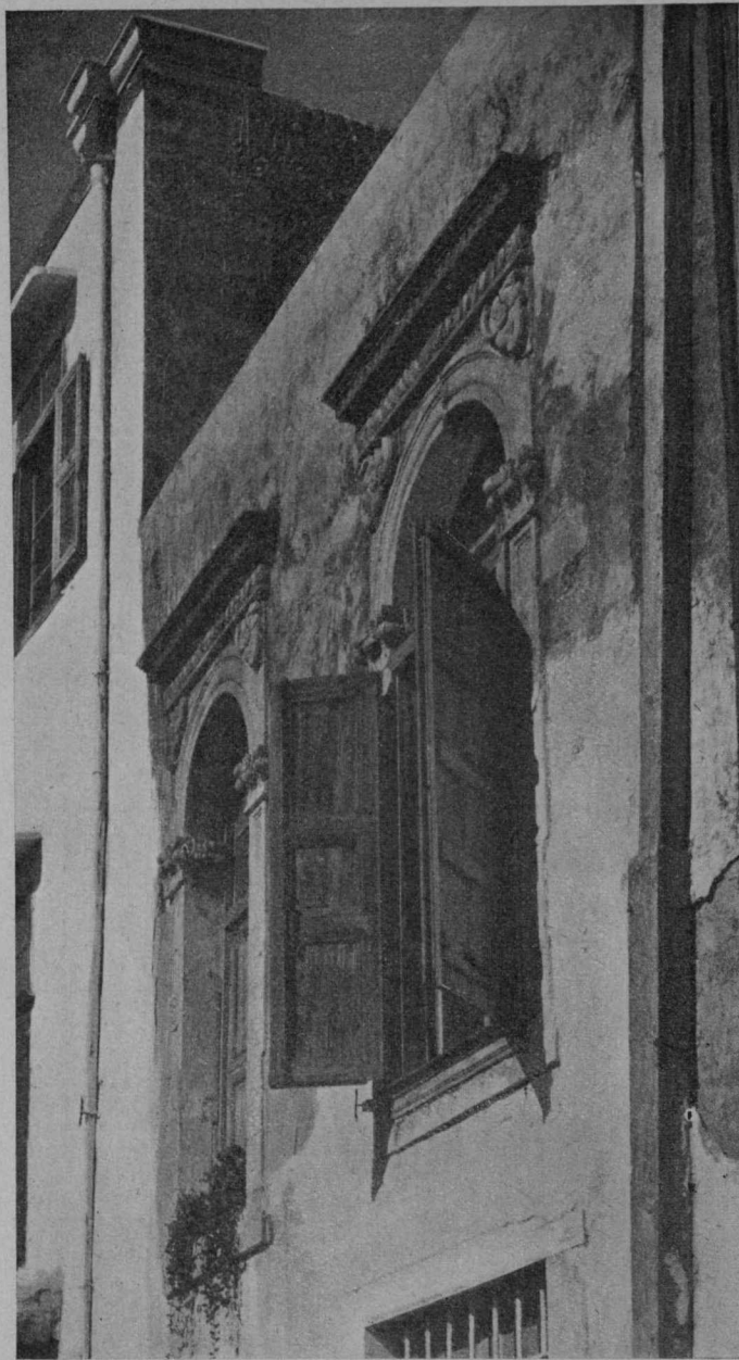
FIG. 148 — RETIMO — FINESTRE IN VIA DELLE SCUOLE. (376).
