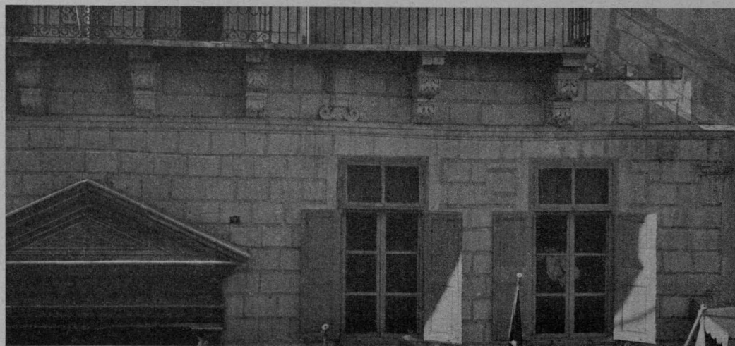
FIG. 142 — RETIMO — PALAZZO IN VIA DELLO ZAR.
