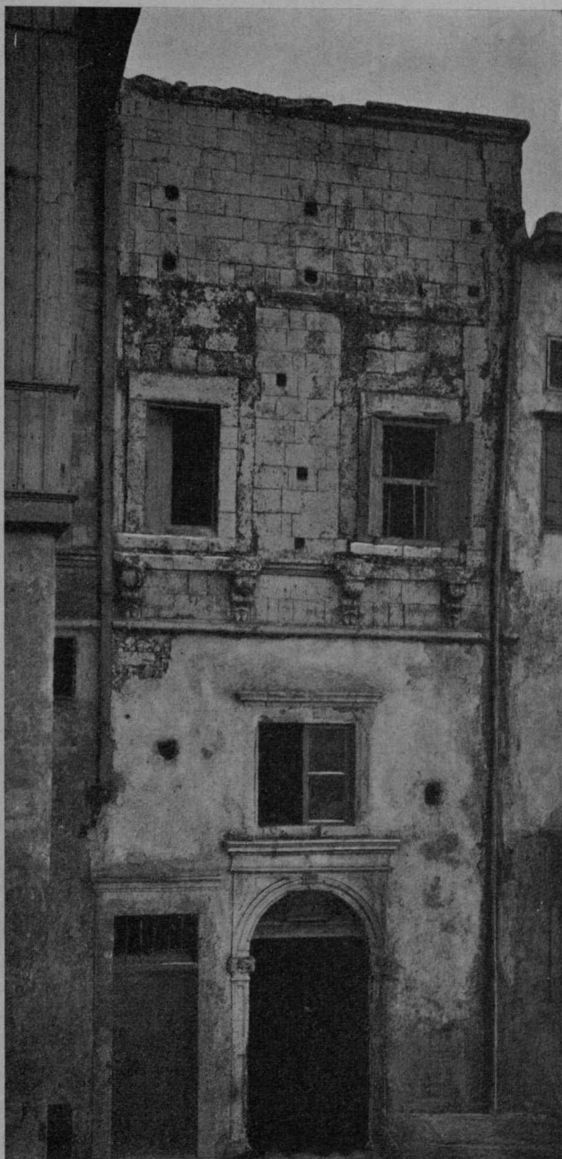
FIG. 140 — RETIMO — PALAZZO IN VIA DELLO ZAR. (367).
