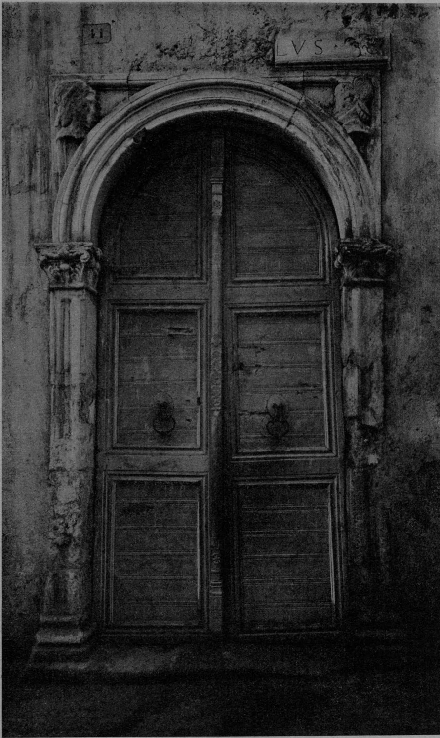
FIG. 152 — RETIMO — PORTALE IN VIA UNIONE. (370).
