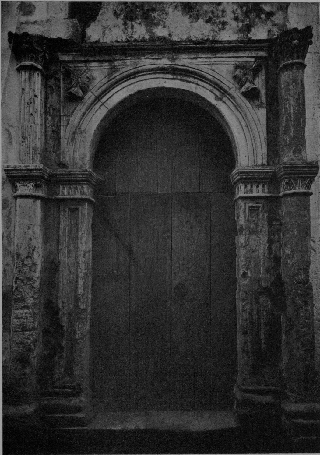
FIG. 147 — RETIMO — PORTALE IN VIA DELLA CHIESA. (371).
