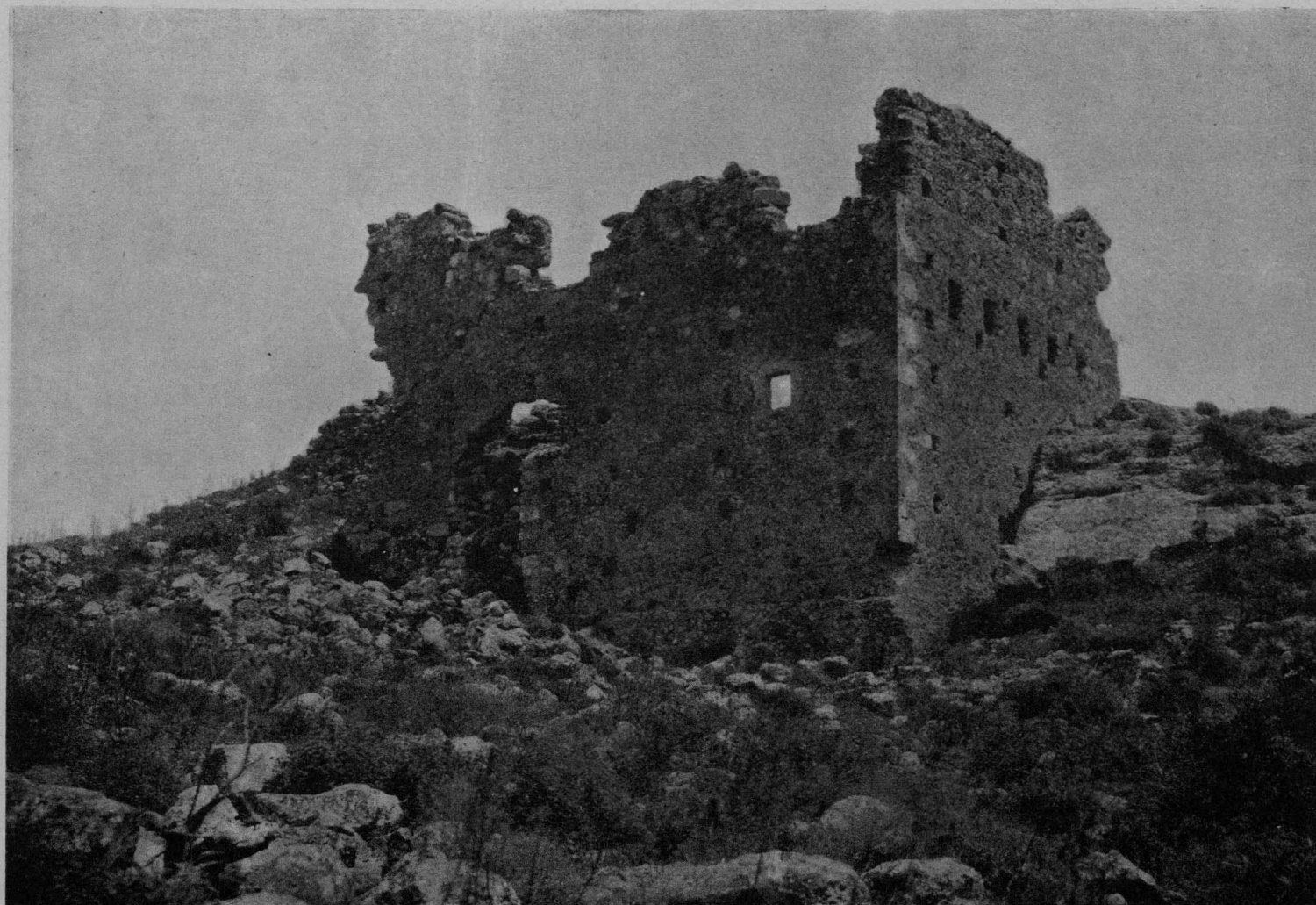
FIG. 204 — * PREVELJANÀ — IL * PÍRGHOS DA SUD-OVEST. (865).
