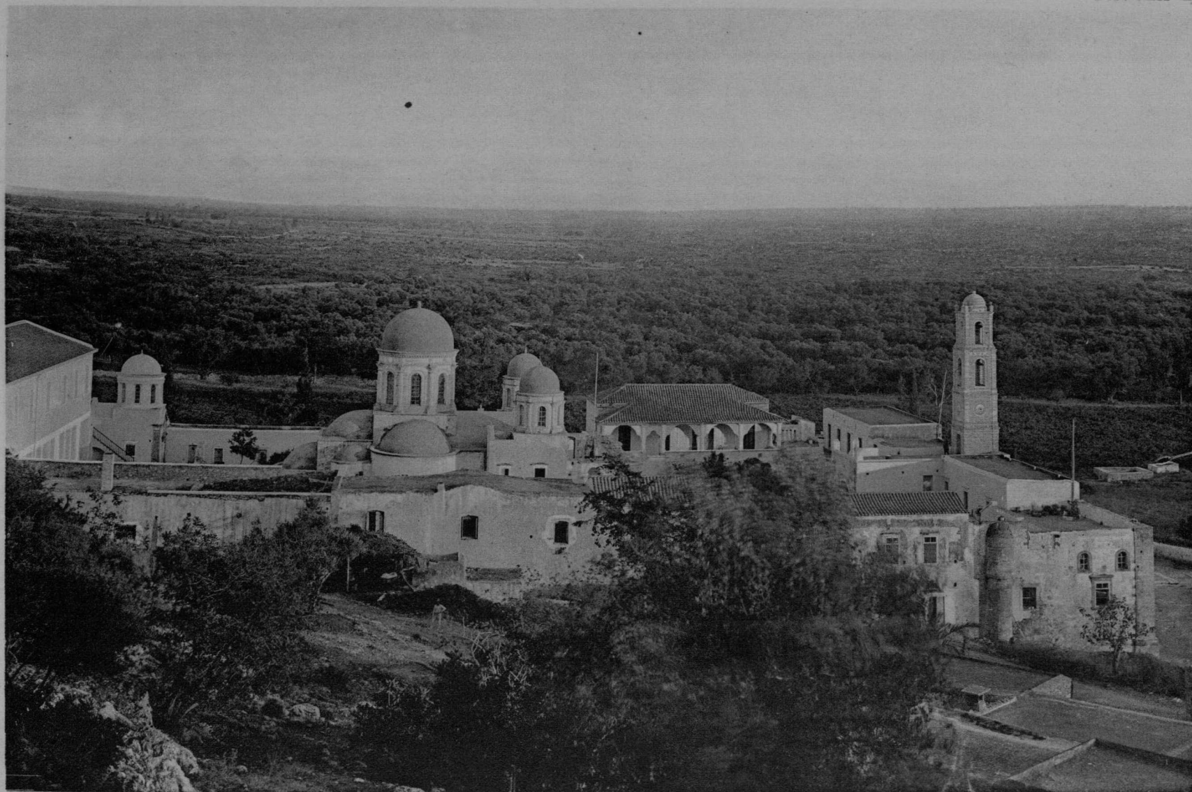
S. TRINITÀ DEI ZANGAROL — IL CONVENTO DA NORD. (470).
