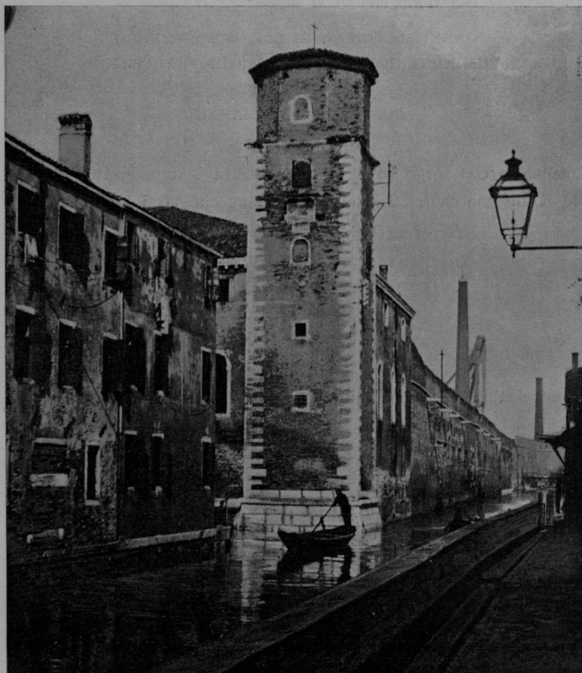
FIG. 5. — Torre di San Pietro e Paolo all'angolo sud-est dell'Arsenale.
