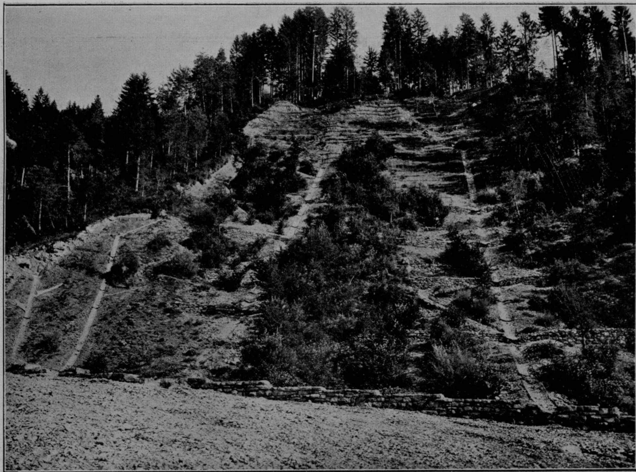
RIO CANONICA — Frana Flassatis in via di sistemazione,
