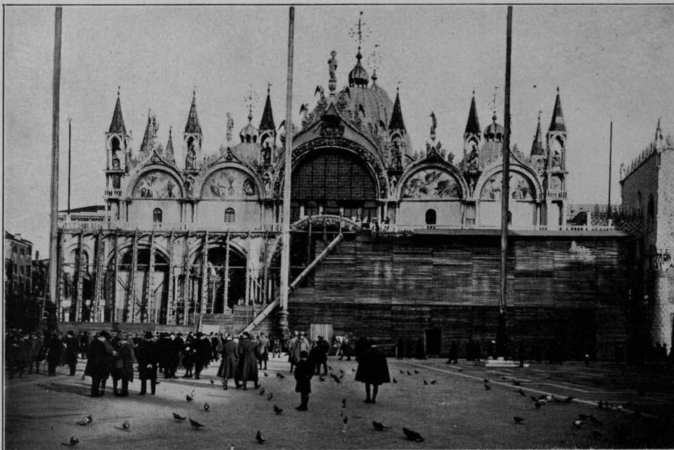
LE DIFESE ALLA BASILICA DI S. MARCO VENGONO DEMOLITE
