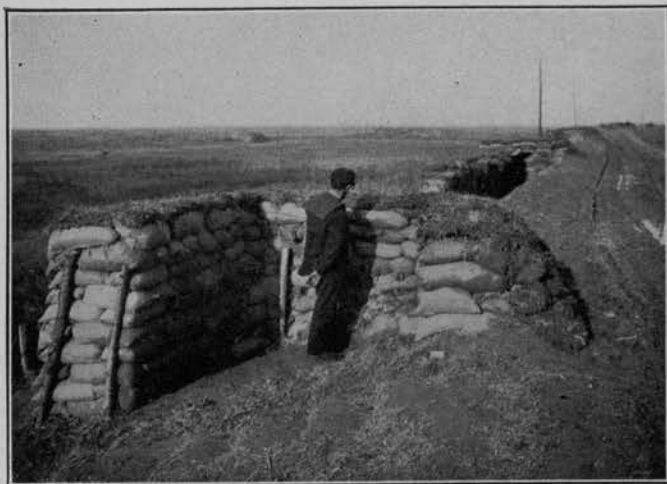
TRINCERAMENTI LUNGO GLI ARGINI DEL PIAVE VECCHIO
