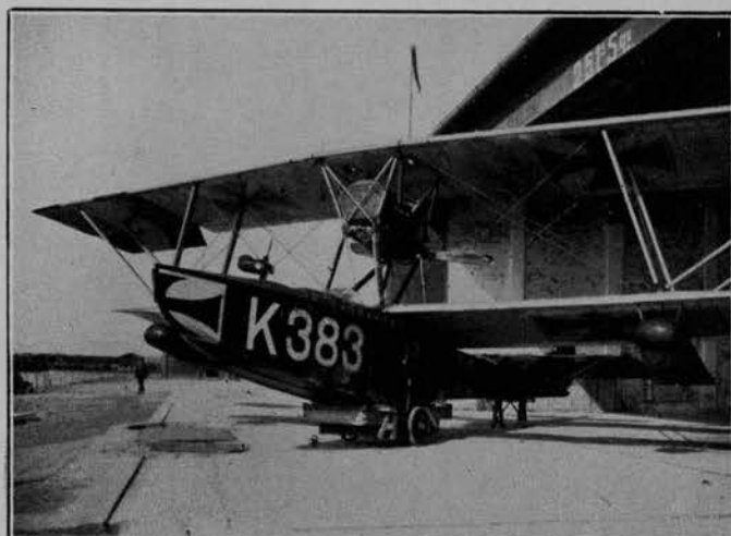
IDROVOLANTE AUSTRIACO CATTURATO SULLA SPIAGGIA DI CORTELLAZZO NELLA NOTTE DEL 19 MARZO 1918 — APERTURA D'ALI METRI 22, MOTORE A 12 CILINDRI; PORTAVA A BORDO 18 BOMBE.
