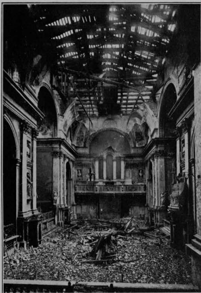
L'INTERNO DELLA CHIESA DEGLI SCALZI DOPO LO SCOPPIO DELLA BOMBA, CHE CAUSÒ IL CROLLO DEL SOFFITTO E LA DISTRUZIONE DEL PREZIOSO AFFRESCO
