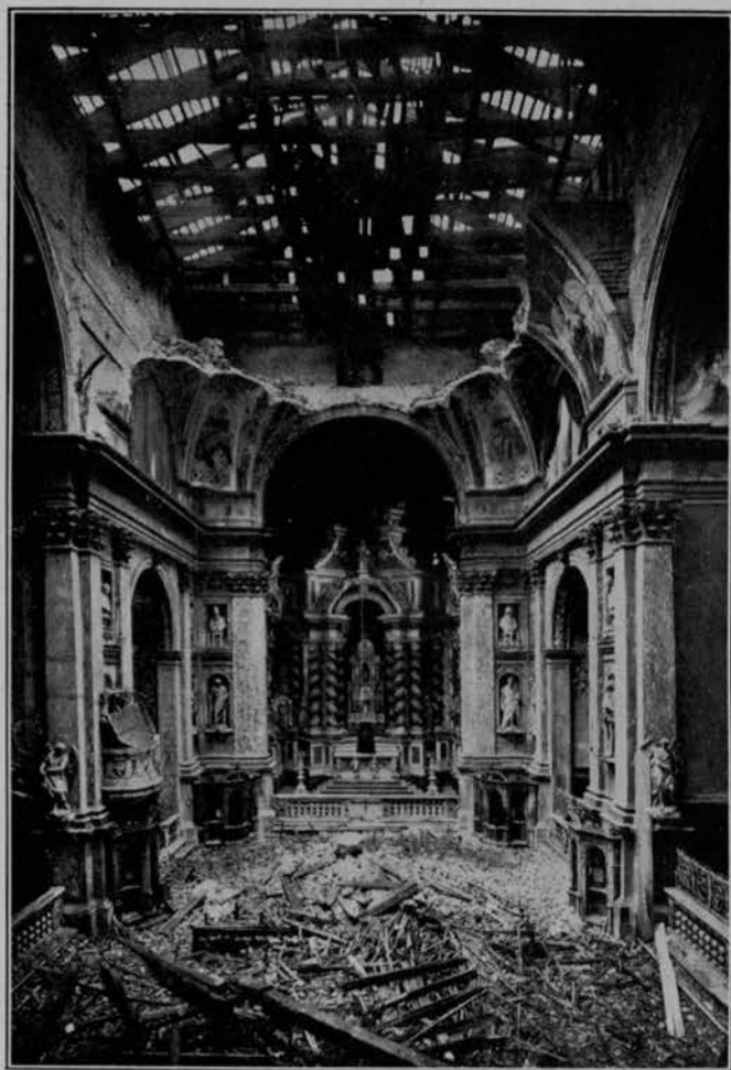
L'INTERNO DELLA CHIESA DEGLI SCALZI DOPO LO SCOPPIO DELLA BOMBA, CHE CAUSÒ IL CROLLO DEL SOFFITTO E LA DISTRUZIONE DEL PREZIOSO AFFRESCO
