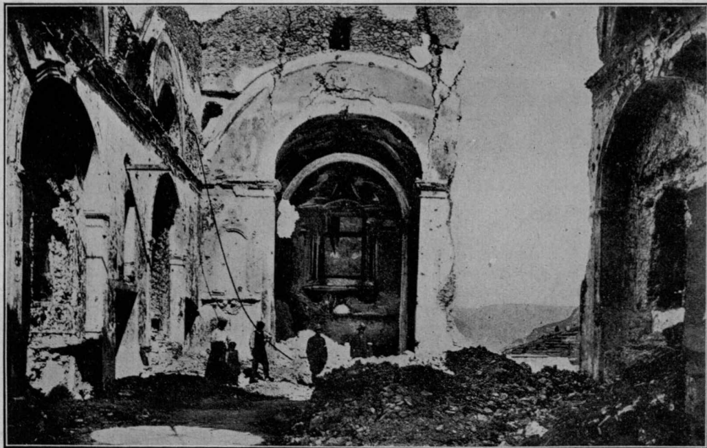
FIG. 518. — VALLARSA - Chiesa parrocchiale (Rovine dell' interno) (nel fondo la grande cornice marmorea).
