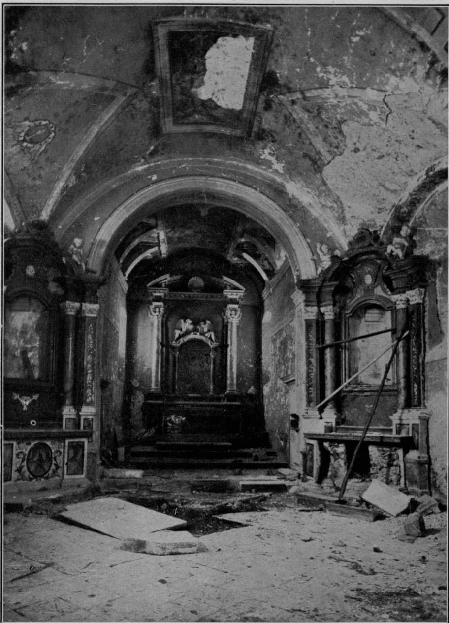
FIG. 543. — CAZZANO - Chiesa della Natività di M. V. I danni dell'interno.
